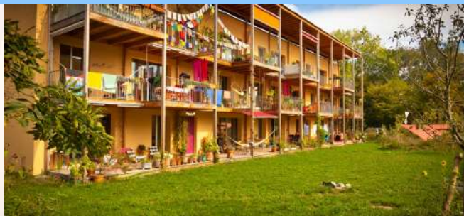
Coopérative Équilibre - Genève Toilettes sèches, réutilisation locale, accompagnement social Source : cooperative-equilibre.ch
